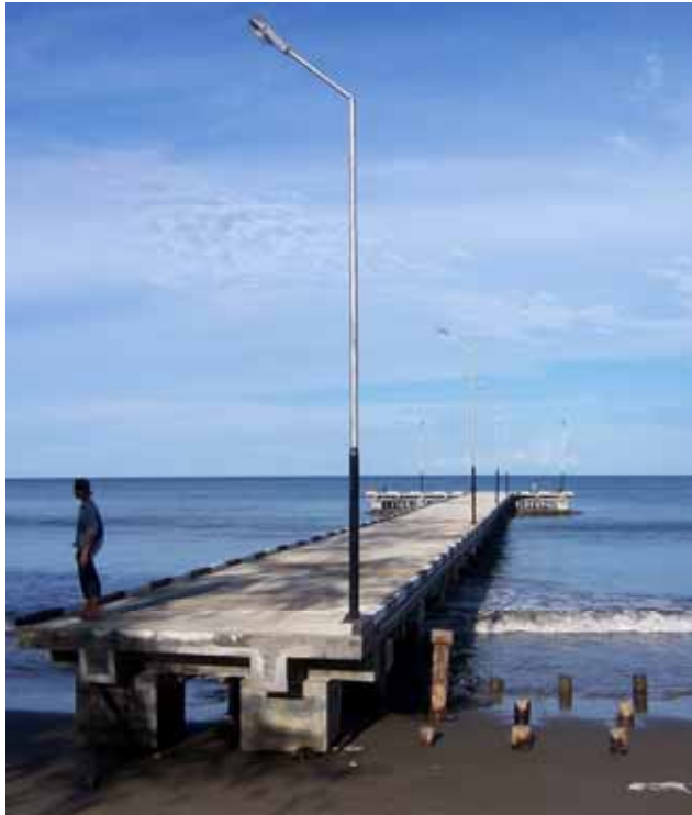
Jetty, Pelabuhan Pendaratan Ikan (PPI) – dibangun dengan dana BRR
