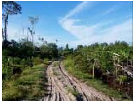
Pembongkaran mangrove untuk fasilitas jalan menuju TPI (mengancam kelestarian mangrove di sekitar Laguna)
