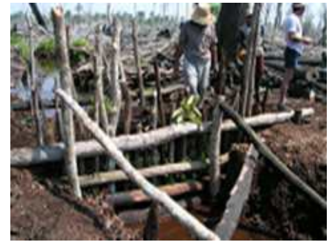
Gambar 2. Upaya rehabilitasi gambut yang mengalami pengeringan melalui penutupan saluran dan rehabilitasi lahan
